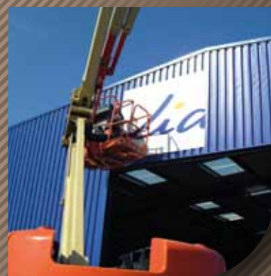
Pose de signalétique
