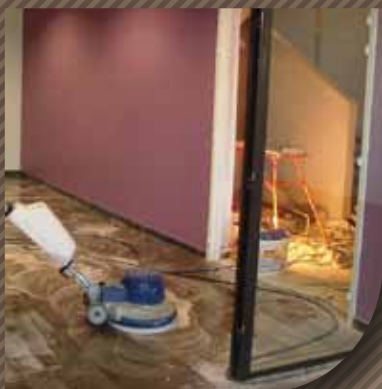
Remise en état
